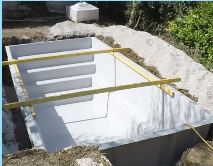
8- Mise en place cadre d'étayage
