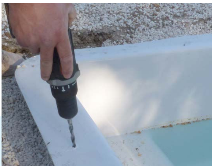
11- Perçage lèvres et raccordement au ferrailage
