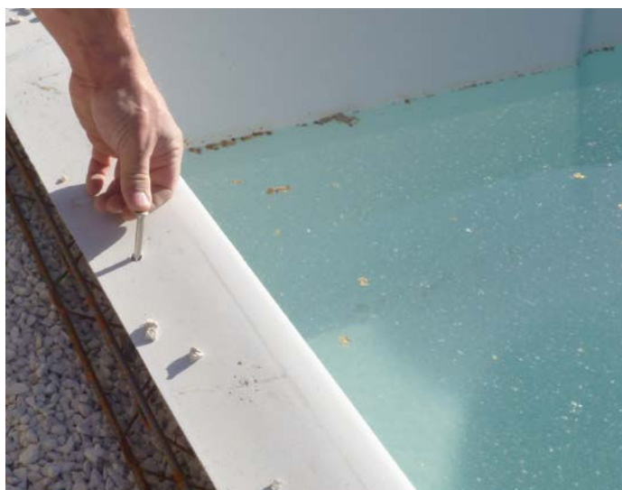
11- Perçage lèvres et raccordement au ferrailage
