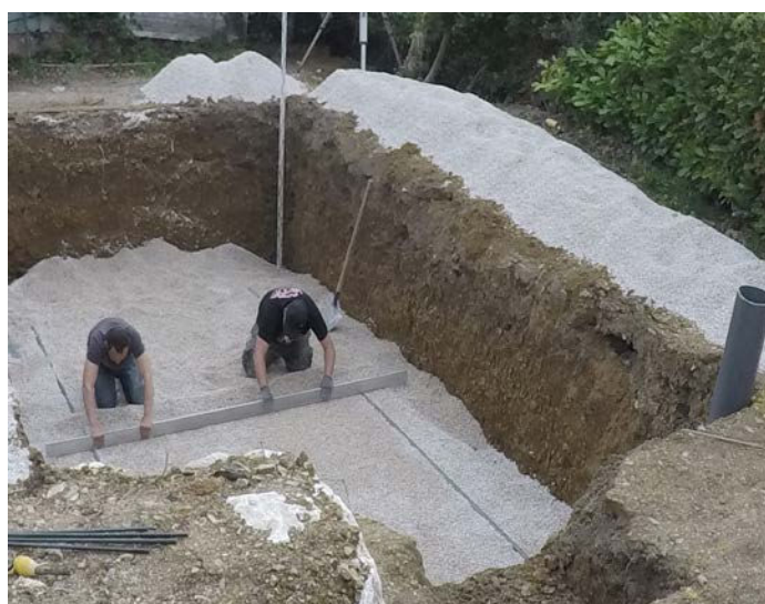
4- Réalisation assise drainante
