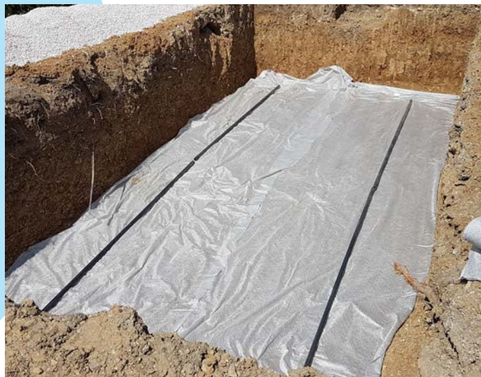
2- Mise en place géotextile
