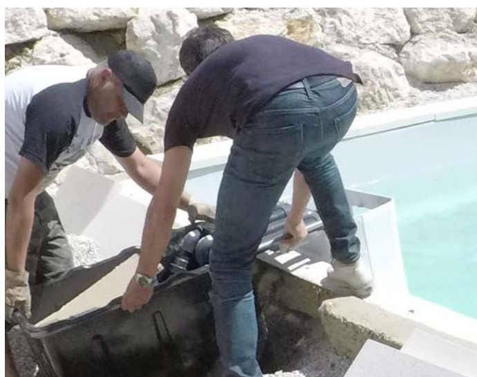
14- Mise en place bloc filtrant
