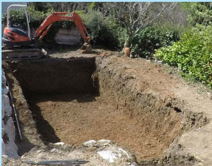
1- Terrassement et fond de fouille propre
