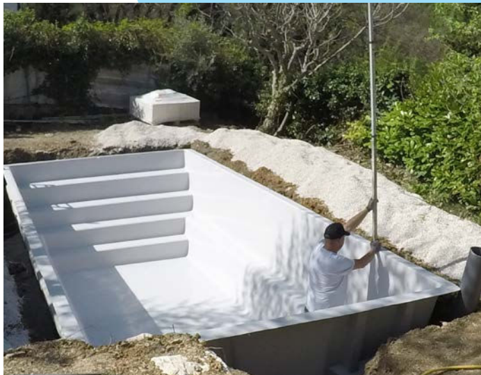
7- Vérification et réglage des niveaux
