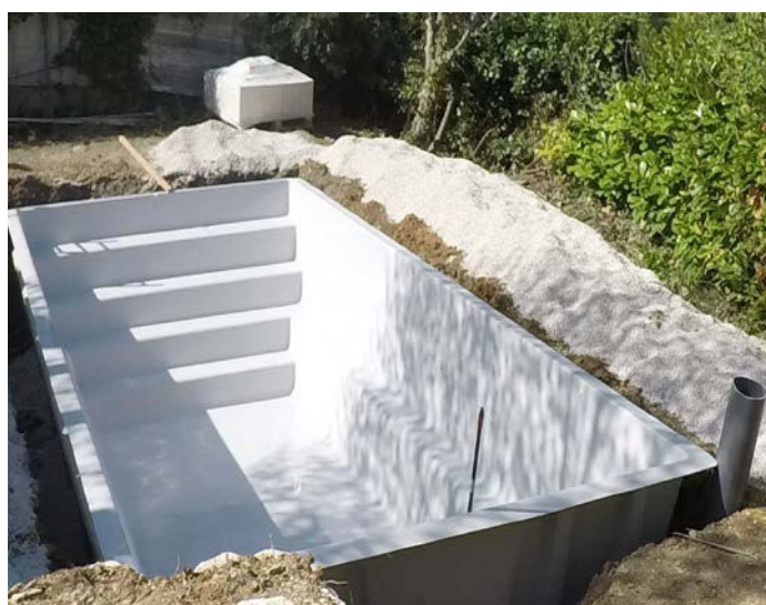
6- Dépose sur assise drainante
