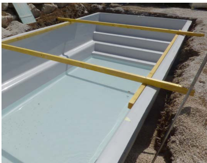
9- Début remblaiement et remplissage
