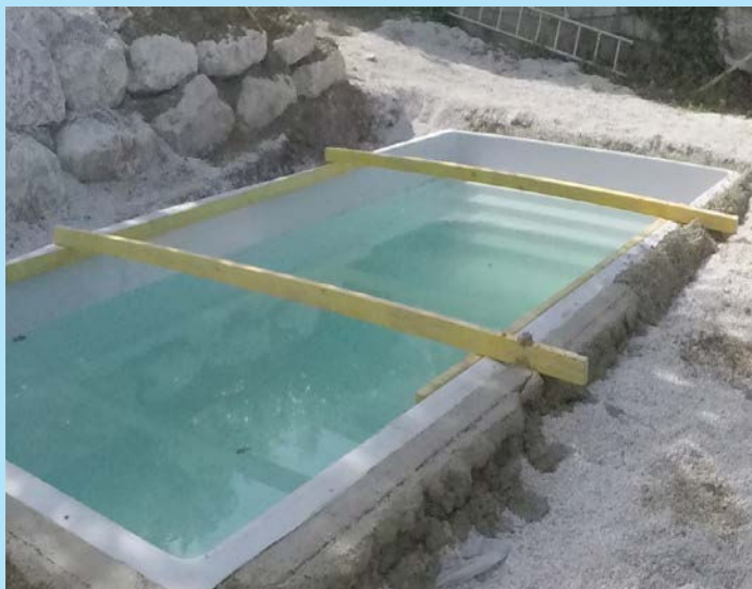
12- Réalisation support éléments de finition en béton
